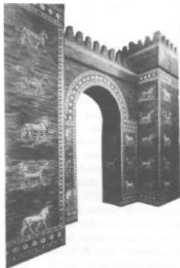
Puerta Ishtar de Babilonia, ubicada en una torre doble de más de 10 m., que guardaba la entrada norte de la ciudad. La construcción muestra las figuras en relieve de toros y dragones en filas alternadas. El ladrillo era el material común de construcción en una zona en que no había piedra. Cortesía Museo Staaliche de Berlín
