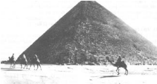
La Gran Pirámide en Giza, construida durante el reinado de Khufu, de la cuarta dinastía (2575-2465 a. de J.C.). El área de la base tiene 230 m.2; la altura original era 146 m. Cortesía Zev Radovan
