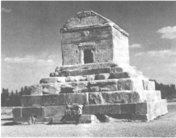
Tumba de Ciro, en Pasargadae (Irán). La tumba está construida con piedra caliza blanca y descansa sobre seis escalones de altura irregular. La pequeña entrada conduce a un cuarto sin ventanas. Cortesía B. Brandl
